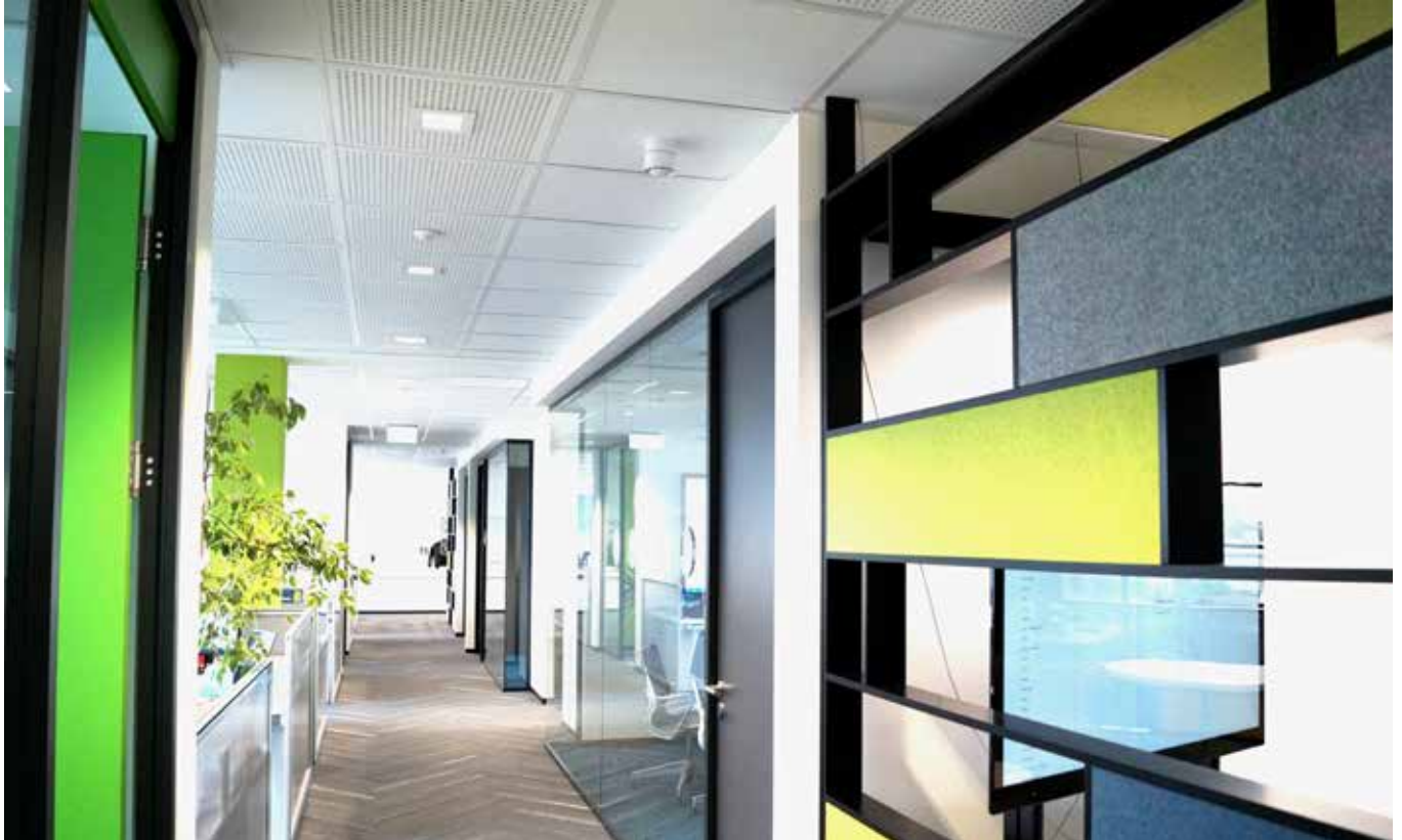
Nach Fertigstellung: Kühlkonvektoren "unsichtbar" oberhalb der Abhängecke
