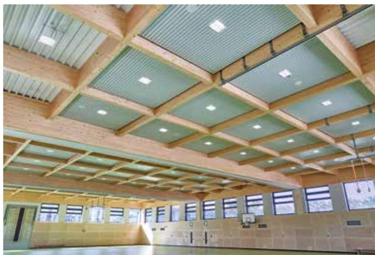
Bindern eingebaut. So entstand eine optisch ansprechende Hallendecke. Die Ausschnitte für die verschiedenen Deckeneinbauten wie LED-Leuchten, Lautsprecher und Datendosen wurden ebenfalls vor Ort gefertigt.
