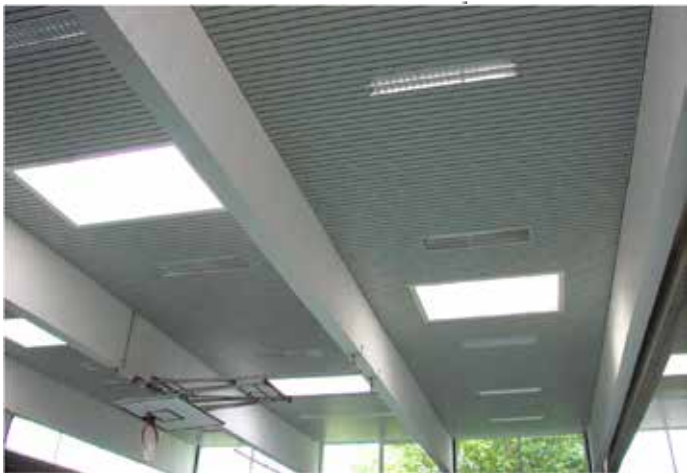
Die ballwurfsichere S-85 Paneeldeckenheizung wurde perfekt zwischen die vorhandenen Binder eingepasst.
